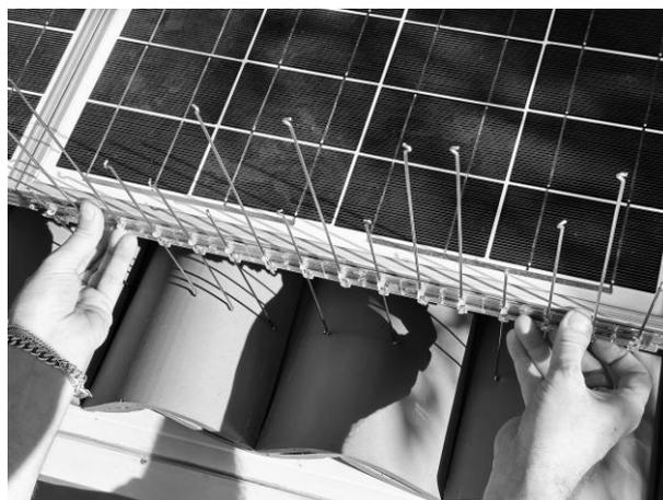
**Nota bene!** I segmenti filiformi inizieranno a scendere autonomamente per effetto gravità scorrendo dentro le proprie sedi di ancoraggio fino ad appoggiarsi alla copertura sottostante in maniera uniforme. Nel caso in cui alcuni segmenti non dovessero scendere autonomamente effettuare una leggera pressione con le mani
