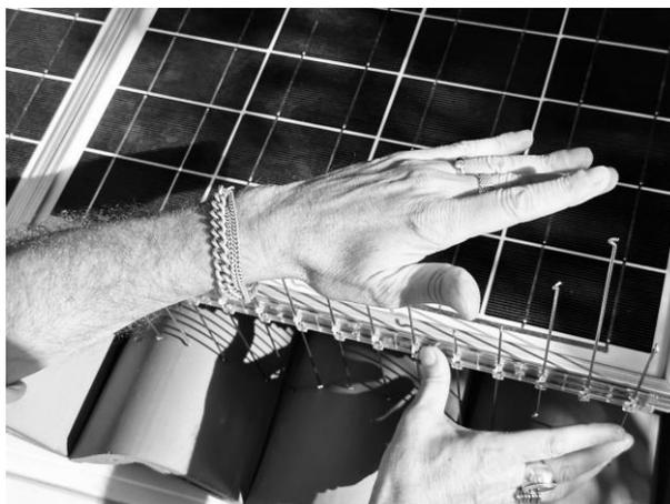
**3.7.5** Effettuare una uniforme pressione con le mani sull'esterno della barriera applicata alla cornice del pannello fotovoltaico premendo la barriera per tutta la sua lunghezza. (vedi esempio sottostante)
