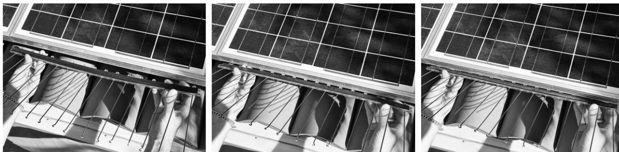
**Nota bene!** In questa fase fare attenzione a mantenere distanziato il nastro adesivo o il silicone dalla cornice del pannello fotovoltaico per evitare l'effetto "stacca-attacca" che danneggerebbe l'efficacia del collante.
